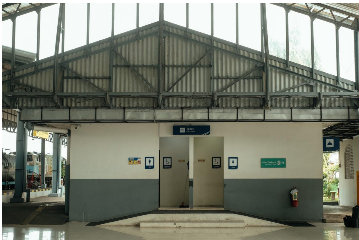
Contoh toilet yang dapat diakses di stasiun kereta api di Solo.
