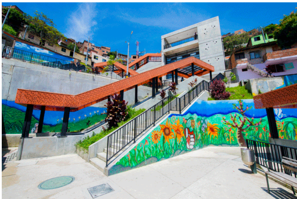
Escaleras eléctricas de la Comuna 13
