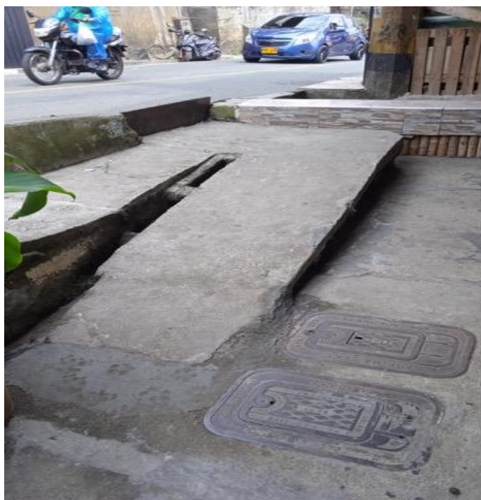
Ejemplo de rampa casera de 10 grados de pendiente
