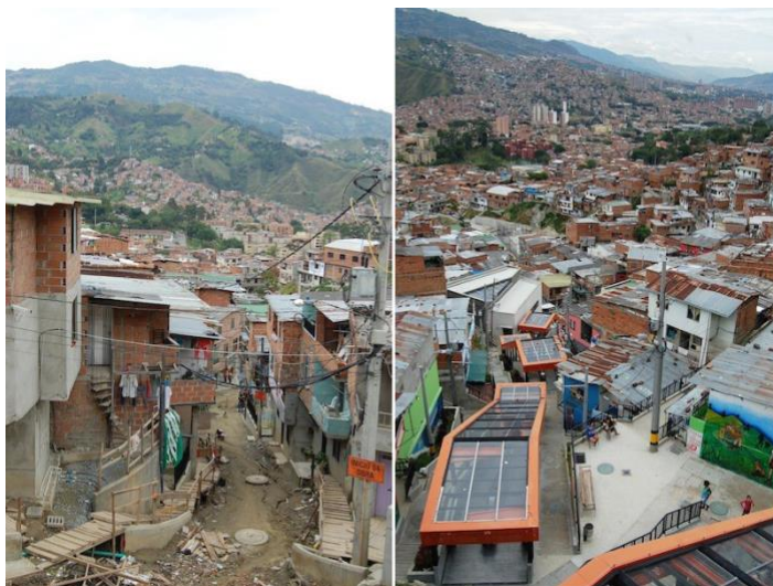
Foto 6 : PUI Comuna 13. Antes y después de las escaleras eléctricas 71
